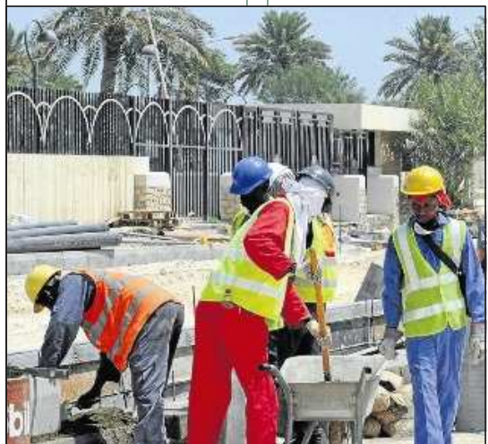
Hunderttausende ausländischer Arbeiter schufteten zu Hungerlöhnen auf den WM-Baustellen in Katar.
